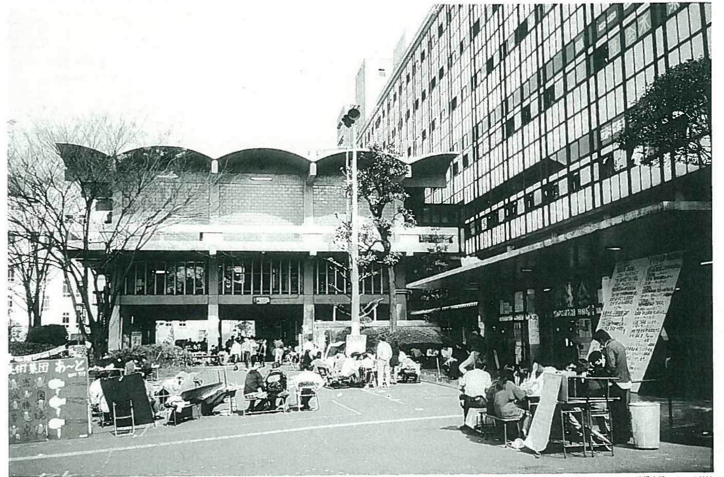
北側庭からみる相貫体シエルによる教授室棟 photo: H.M.
