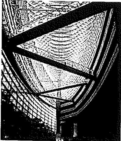
まず始めに行った東京国際フォーラムは 1998 年に竣工、鉄筋コンクリート造で上部には巨大な船の形をしたアトリウムが左右のワイヤーによって支えられている。これを見たときは圧倒されてしまって言葉がでなかった。TA の人の説明によると、この大きな「船」を支える左右のワイヤーがもし万が一切れてしまうと、とたんに不安定になってしまいうときいてとても繊細な建築だと思った。
